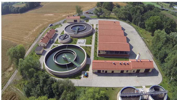
Nowa oczyszczalnia ścieków
